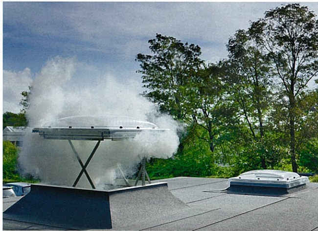
VELUX Brandrauch-Flachdach-Fenster: Der Fensteröffner mit Scherenbeschlägen hebt die Kuppel samt Fenster vollautomatisch in kürzester Zeit vom Dach ab.
